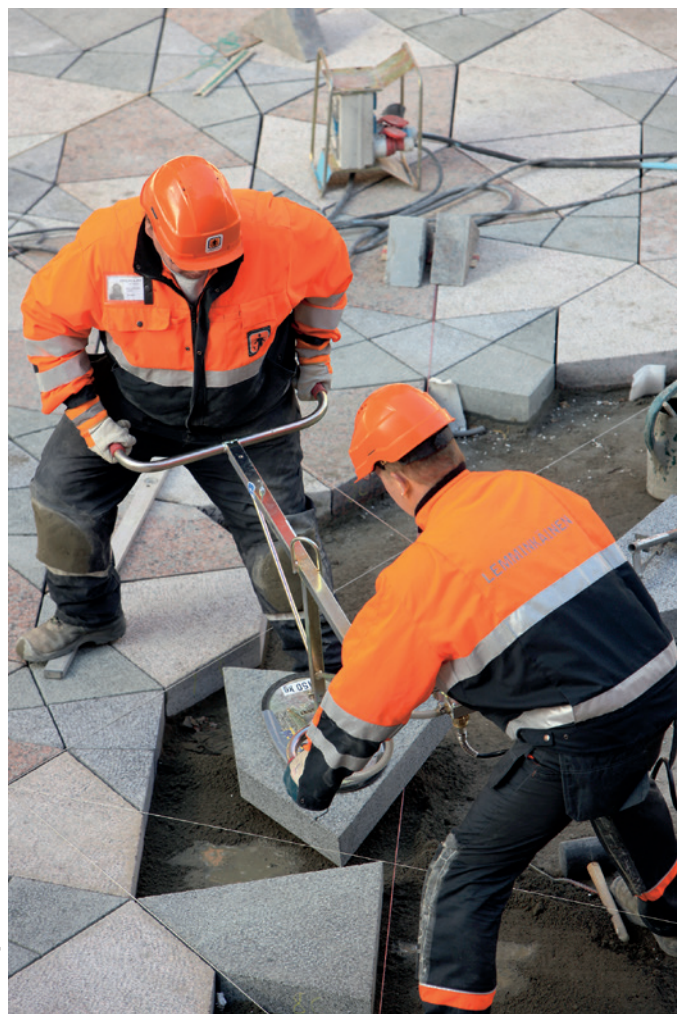
7 Kadun sulanapitojärjestelmän energia tulee kaukolämmön paluukierrosta.
