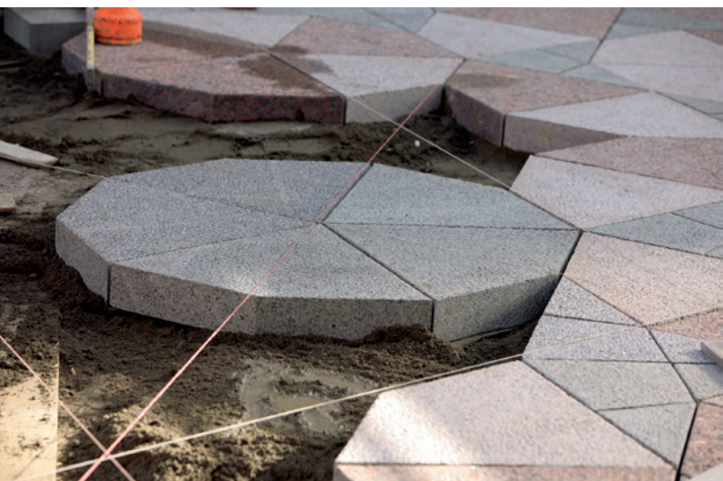
6 Kivet asennettiin maakostean betonin. Graniittikivien pinta on ristipähakattu.
