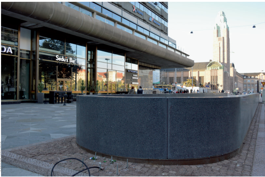
9 Pysäköintihallin kaide ja kaiteen U-muotoon kaartuva pääty toteutettiin hiotuilla betonielementeillä.
