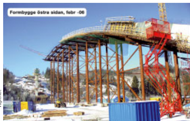
5 5 Itäpuolen holvikaaren muottien tukirakenteina käytettiin teräspilareita.
