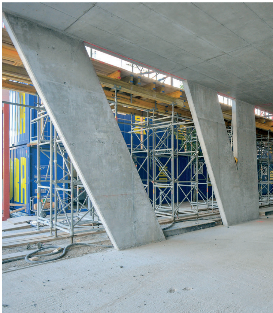
8 Rakennus on paikalla valettu ja rakennettu. Cemex Deutschland AG toimitti kohteen betonit.
