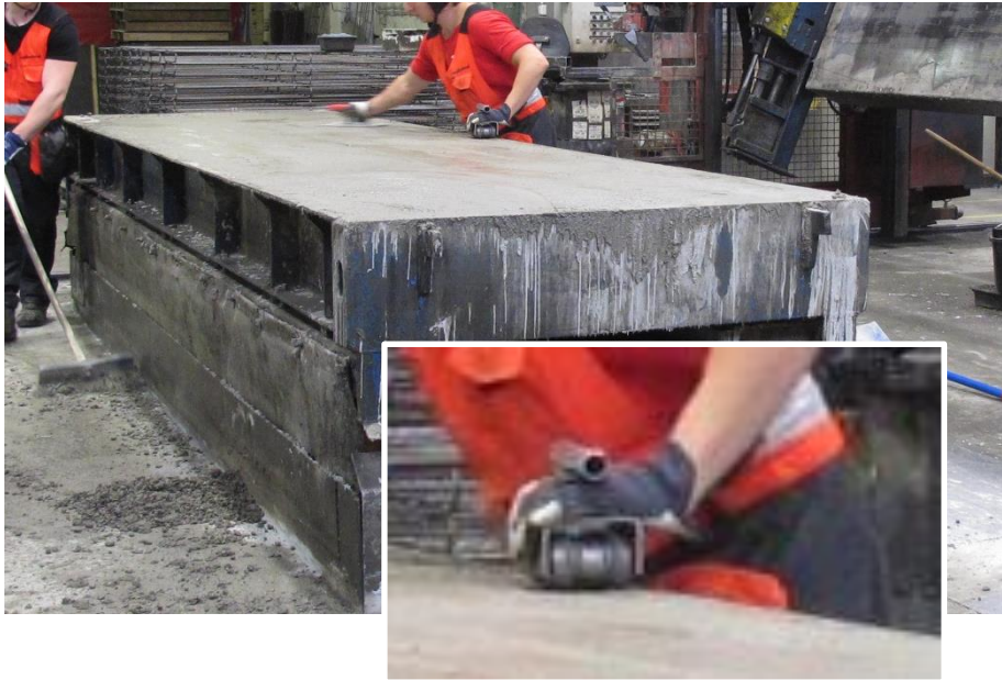
Lujabetoni Oy Siilinjärven maatalouselementtitehdas Pekka Kokkonen
