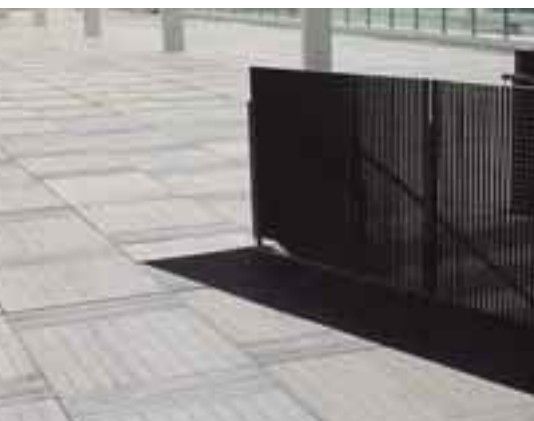
16 Cosmo Caixa, Barcelonan uusi tiedemuseo. Arkkitehdit Esteve ja Robert Terradas 2004. Piha ja pihaan liittyvät aulatilat on päälystetty kohteeseen erikseen suunnitelluilla, erehdyttävästi puulaudoitusta imitoivilla betonielementeillä.
