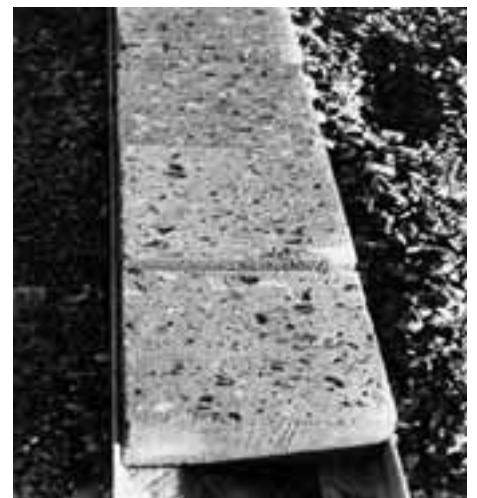
2 Betonikoekappaleet teräksisessä kehyksessä koekentällä /2/.
