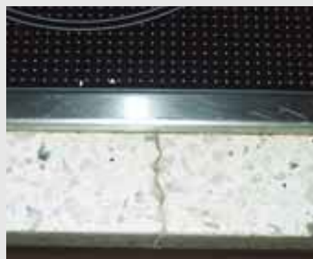
Epoksilla paikattu isokin halkeama pysyy siistinä.
