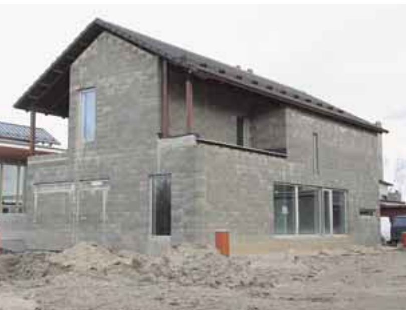
Talo Kumpeli on rakennettu betoniharkoista.
