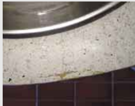
Epoksilla paikattu isokin halkeama pysyy siistinä.
