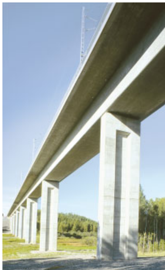
1 Luhdanmäen rautatiesilta on jännitetty betoninen jatkuva kotelopalkkisilta Kerava-Lahti-oikoradalla. Sillan suunnittelijoina ovat toimineet SuunnitteluKORTES Oy ja Arkkitehti toimisto Jussi Tervaoja Oy. Kerava-Lahti-oikorata valittiin Vuoden 2006 Betonirakenteeksi.
