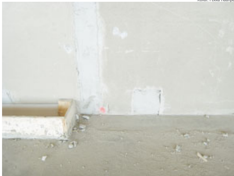
2 Sauman pumppauspuoli ja sauman pistekolo hyvin viimeistelytynä. Tarvittaessa seinän vaakasaumassa käytetään painevalua.
