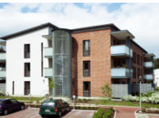
12 HOAS Matinkylä Espoossa on hyvä esimerkki laaduk- kaasta opiskelijajäsenasuntoalueesta. Kohteen muuraus on tehty taustapintapintaisilla punaisenkirjavilla tiilillä ja osittain talojen julkisivut on yksikerrospintattu hiertäen. Arkkitehtitoimisto ArkOpen Oy.
