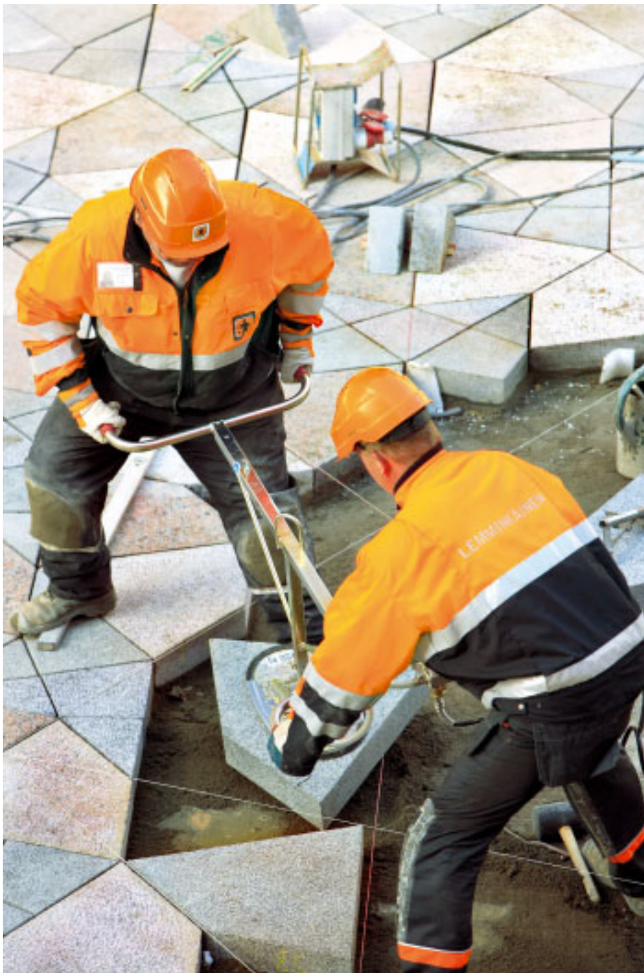
4 Laattojen pinta on käsitelty ns. karkealla ristipähakkauksella ja laatat hakataan Kiinassa kaikki käsityönä. Päälystekiveys asennetaan maakostean betonin varaan. 5 Sulanapitojärjestelmä toimii kaukolämmön paluuviedellä ja lämmitysputket suojataan kuitubetonilla.
