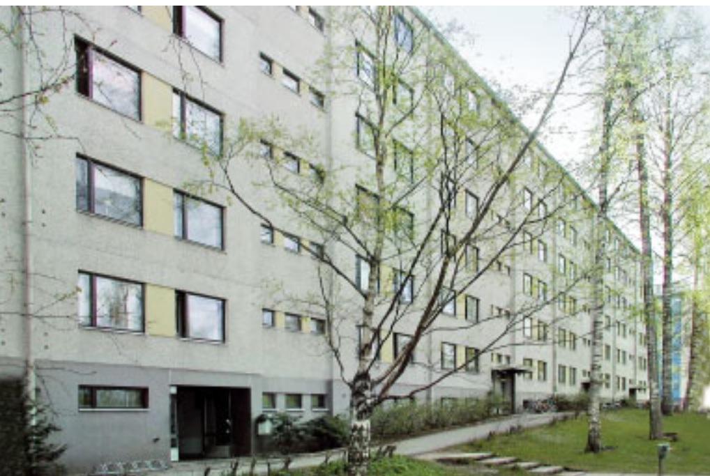
1 Asunto Oy Myyränkolan katujulkisivu ennen korjausta.
