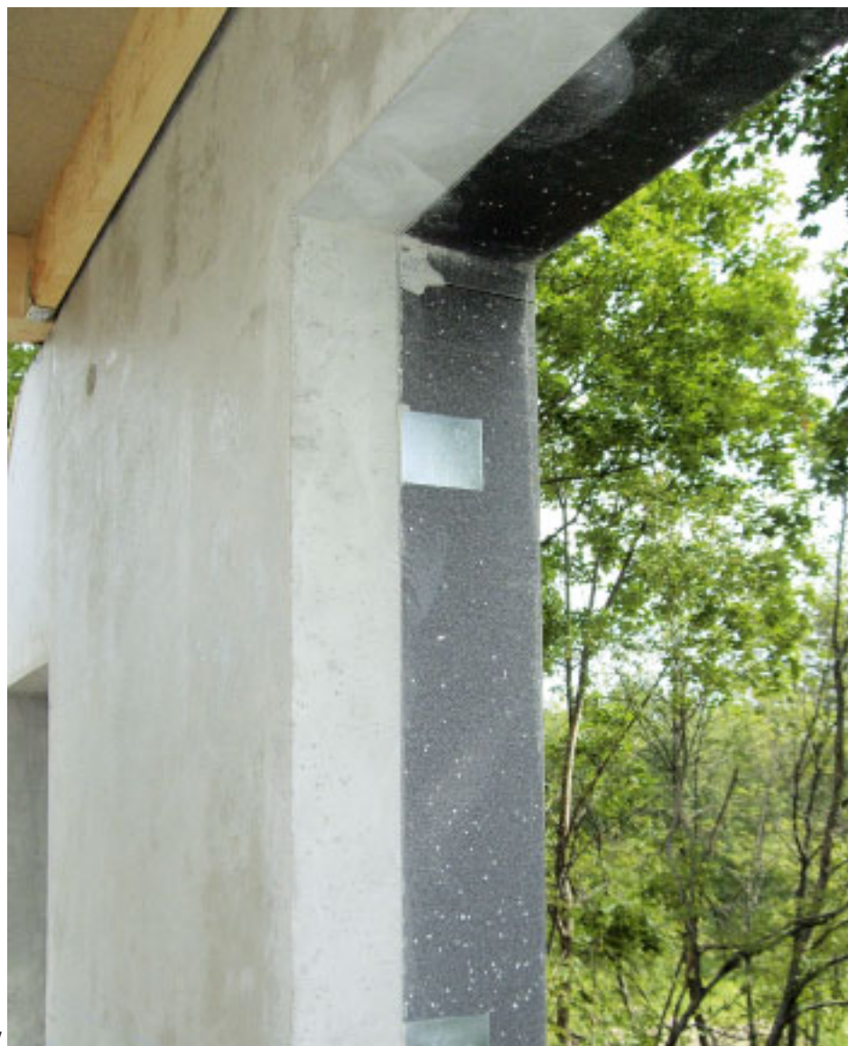
7 Thermisol Platina -eristeen ja seinärakenteen ikkunaliitos.
