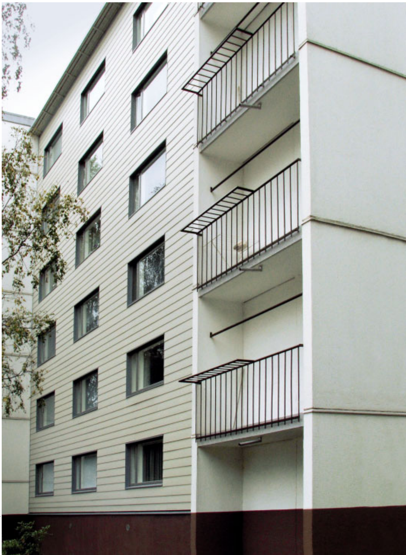
5, 7 Vantaalla sijaitsevan Asunto Oy Martinlukon katujulkisivu ennen korjausta ja julkisivukorjauksen jälkeen.
