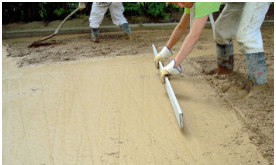
4 Leimasinbetonin minimilujuus on C25/30, maksimiraeko-ko massassa ei saa ylittää 16 mm.
