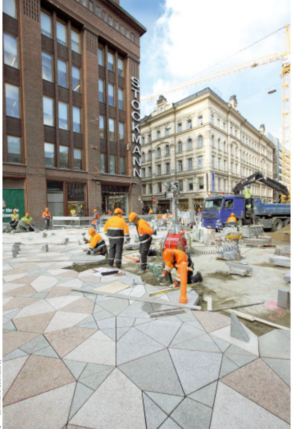
Lemminkäinen Betonituote Oy
