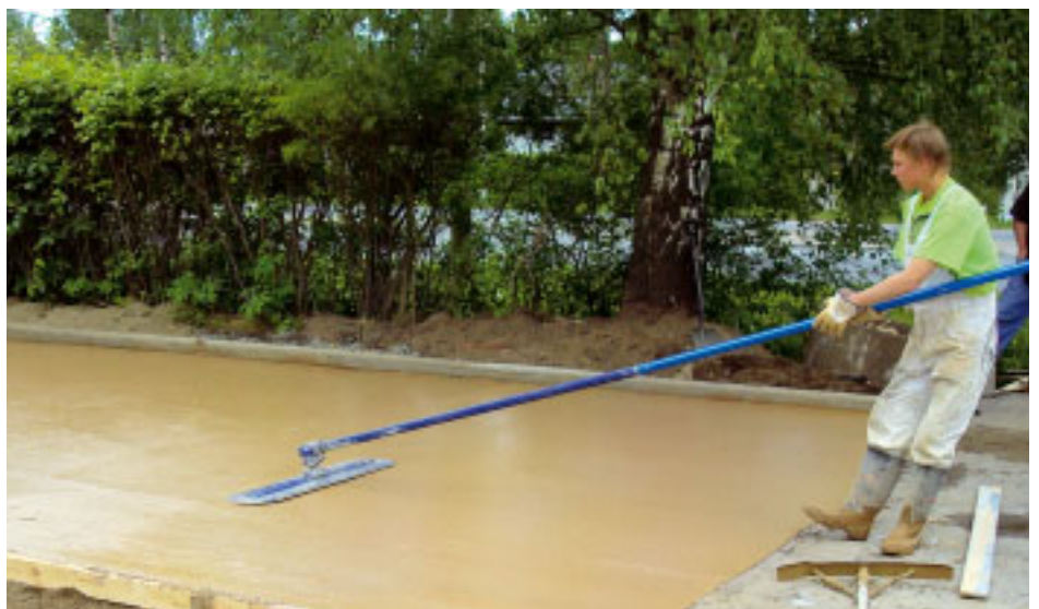
5 Betoni tasataan haluttuun korkoon linjaarilla, pinta vedetään sileäksi ja siitä poistetaan ilmakuplat leveällä tasoiuslastalla, "slodalla".
