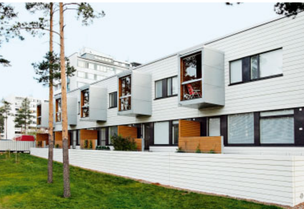
4 Asunto Oy Helsingin Pasaatituulen uritetussa valkobetoniulkisivuissa on yhdistetty puu- ja metalliverhousosia.
