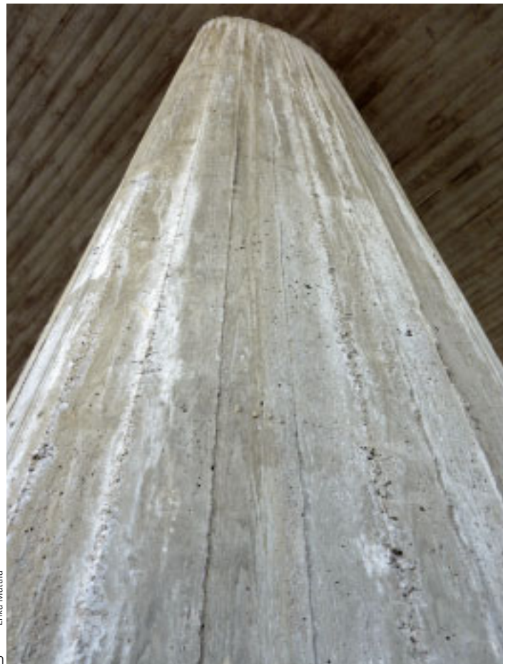
10 Pilarin valupintaa. Laidoitukseen käytettiin sahatavaraa rakenteen vapaan muodon takia.
