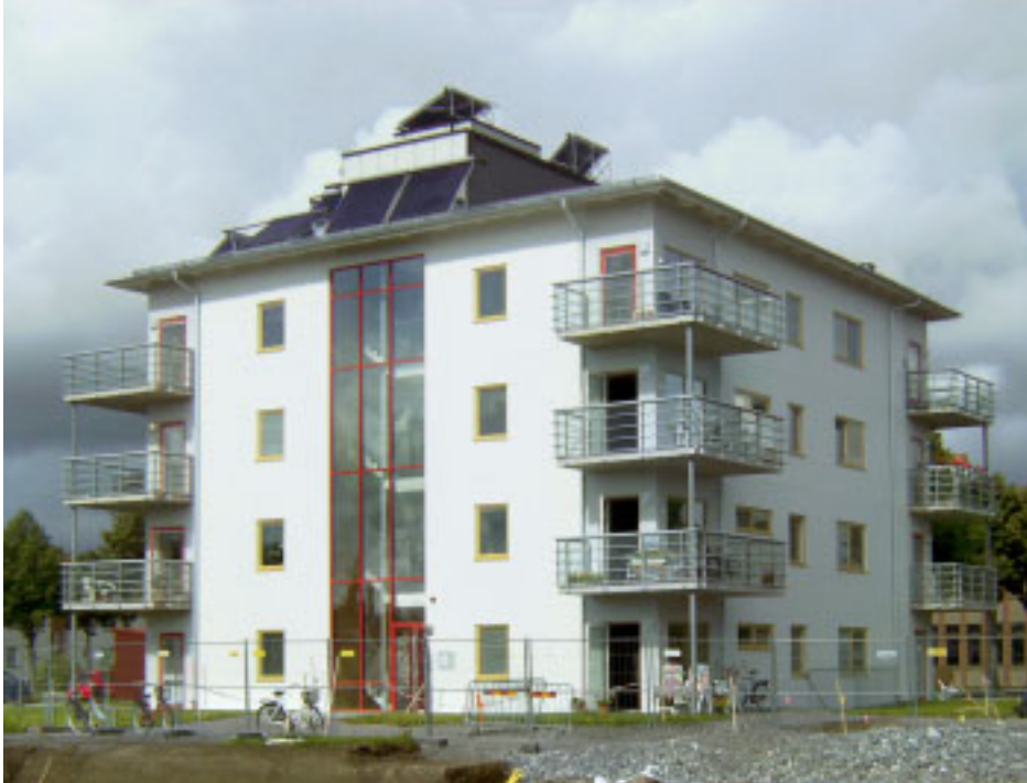
8 Valmistumassaoleva ensimmäinen passiivienergiakerrostalo ThermoDeck-järjestelmällä. Vara, Ruotsi.
