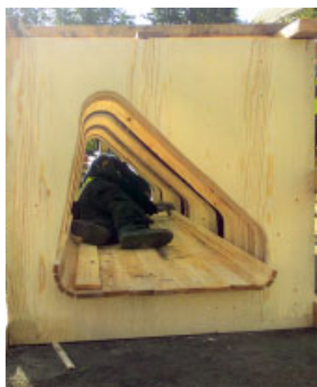
15 Pilarimuotin pystylaudoituksen tekoa.
