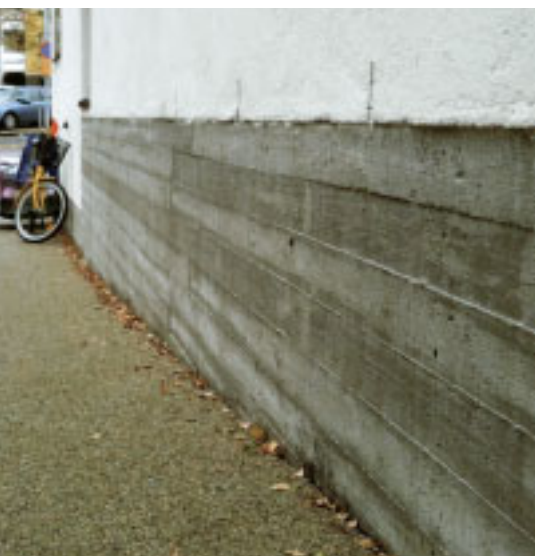
14 Julkisivujen perinteisen kolmikerroskalkkirappauksen alla on paikallavalusokkelit.
