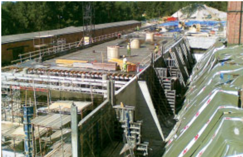
7 Näkymä työmaalta kirjaston alueelta kesällä 2009.
