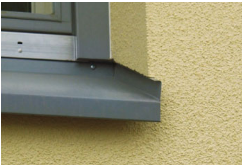
9 Esimerkki rappausreunalla toteutetusta ikkunan vesipelistä.
