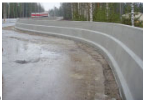
8, 9 10 Valukonetta ohjataan ohjurikiskojen avulla tai epätasaisella alustalla voidaan käyttää linjalankaa. Valmis kaide voidaan verhoilla erilaisilla säleiköillä tai jättää betonipinnalle.
