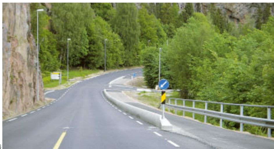
6, 7 Autotien ja kevyenliikenteen väylän välinen matala keskikaide. Matala keskikaide erottaa kevyenliikenteen väylän turvallisesti ajoradasta. Kuvassa 7 matalan kaiderakenteen poikkileikkausesimerkki.
