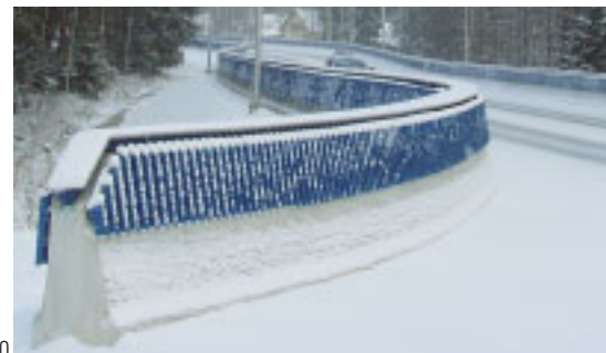
Liukuvalettu betonikaide mukailee tien muotoja, se kestää hyvin kulutusta, pakkasta ja suolaa. Yhtenäisenä rakenteena kaide estää liikenteen aiheuttamia myrkkypäästöjä kulkeutumasta pois tiealueelta pohjavesiin. Saumoja on vähän verrattuna elementtirakenteisiin kaideratkaisuihin.
