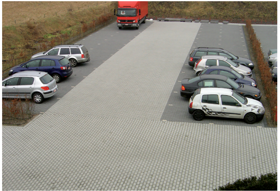
18 Vettä läpäisevä betonikivipinta. Parkkipaikka.
