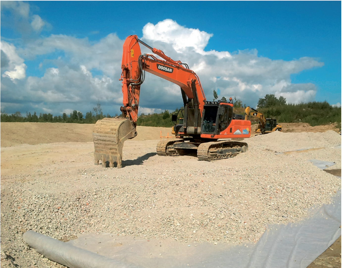
5 Kierrätettyä betoni- ja tiilimursketta käytetään eniten maarakentamisessa, jossa se korvaa paremman kantavuutensa vuoksi 1,5-kertaisen määrän neitseellistä kiviainesta.
