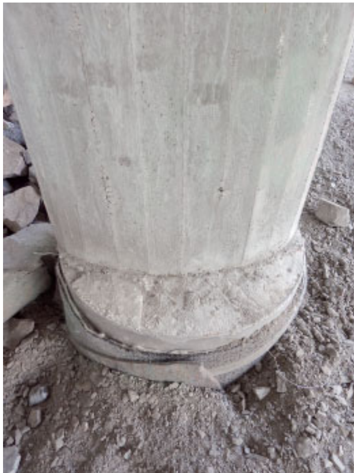
9 Soikea pilari liittyy porapaaluun.
