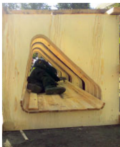
15 Pilarimuotin pystylaudoituksen tekoa.
