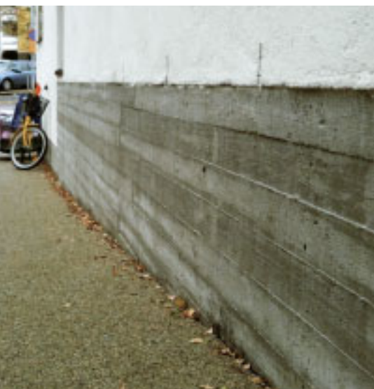
14 Julkisivujen perinteisen kolmikerroskalkkirappauksen alla on paikallavalusokkelit.
