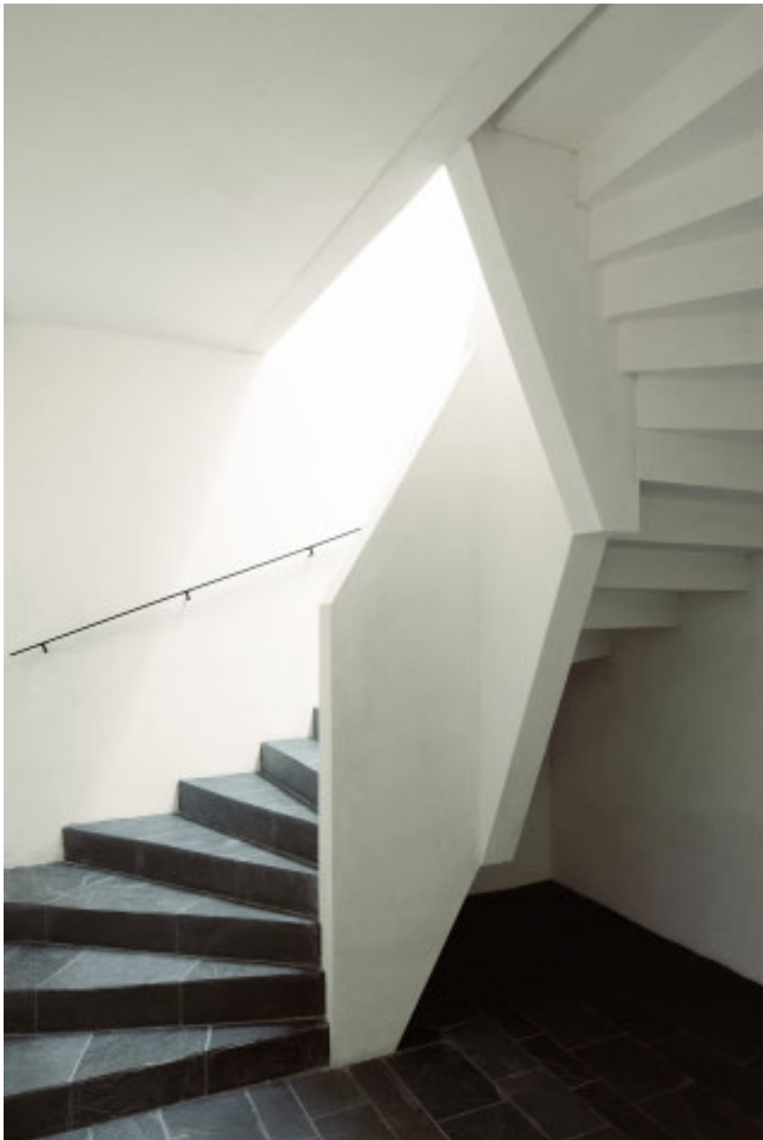
16 - 18 Hyvästijättötilaan johtavat valkobetonirakenteiset paikalla valetut portaat.
