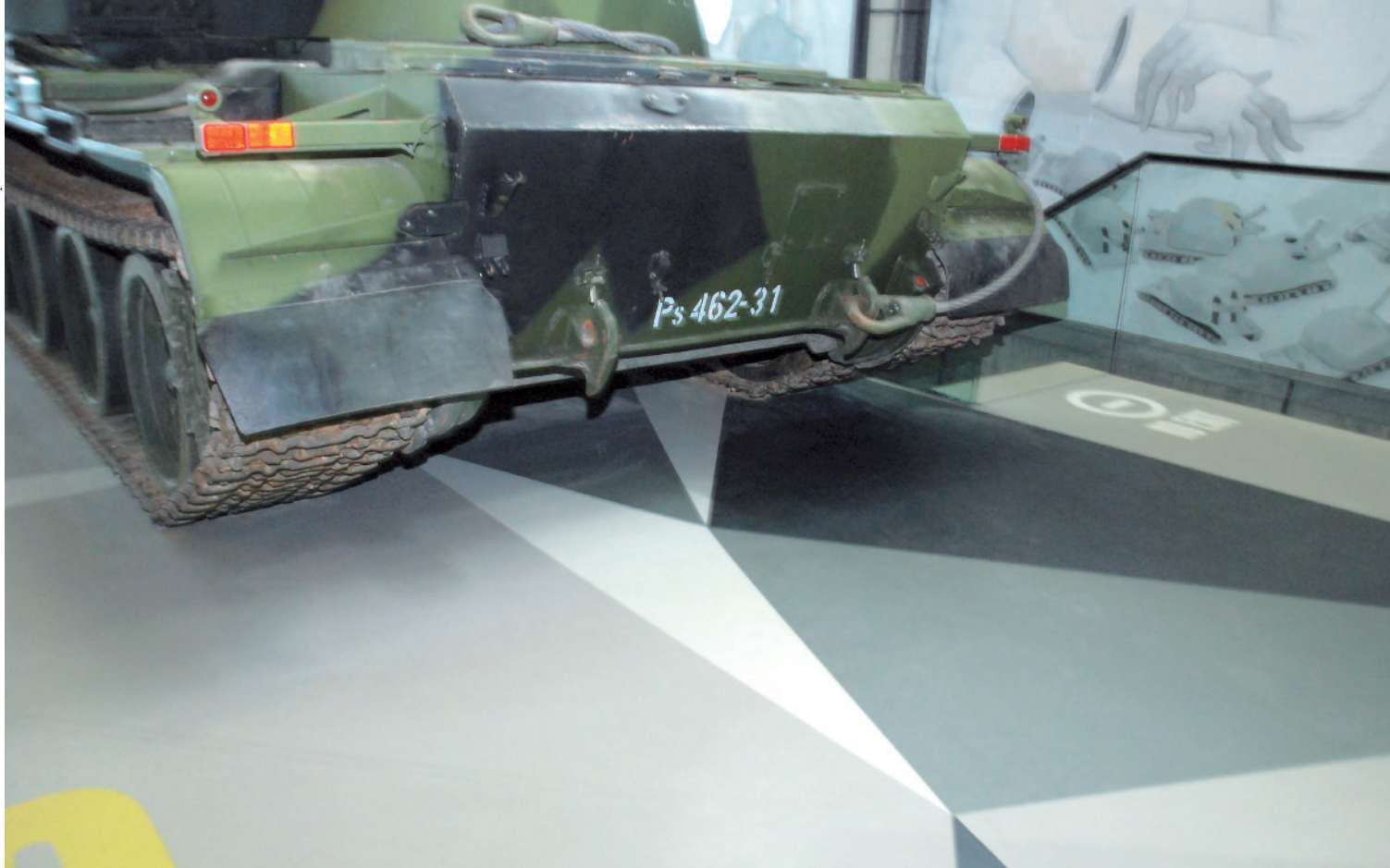
8 Tykkitasanteen lattioissa vaihtelevat Temafloor P300-epoksinnoitteen harmaat sävyt. Päällimmäisenä on himmeä polyuretaanilakka.
