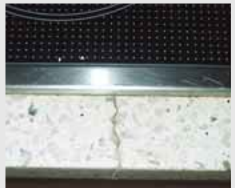
Epoksilla paikattu isokin halkeama pysyy siistinä.
