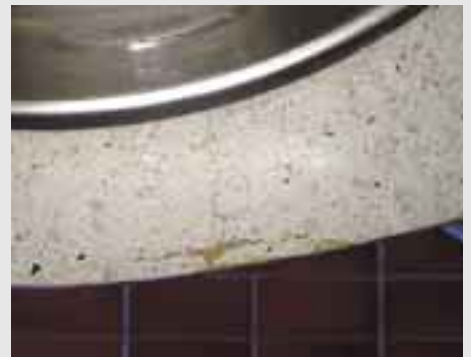
Epoksilla paikattu isokin halkeama pysyy siistinä.
