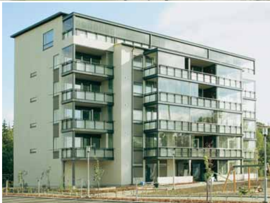
9 Kiinteistö Oy Leevin Palvelutalo, Helsinki. Sollamo Oy: Paavo Sollamo.
