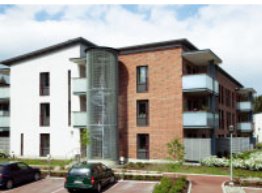
12 HOAS Matinlahti Espoossa on hyvä esimerkki laadukkaasta opiskelija-asuntoalueesta. Kohteen muuraus on tehty taustapintaisilla punaisenkirjavilla tiilillä ja osittain talojen julkisivut on yksikerrosrapattu hiertäen. Arkkitehtitoimisto ArkOpen Oy.
