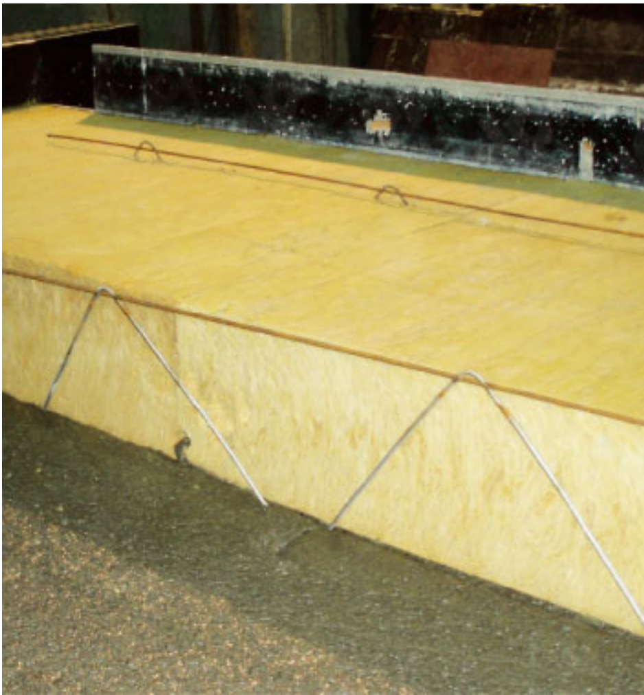
3,4 Betonisandwich-elementti, jossa lämmöneristeenä on 240 mm mineraalivillaa valmistusvaiheessa ja valmiina. Suutarinen Yhtiöt.
