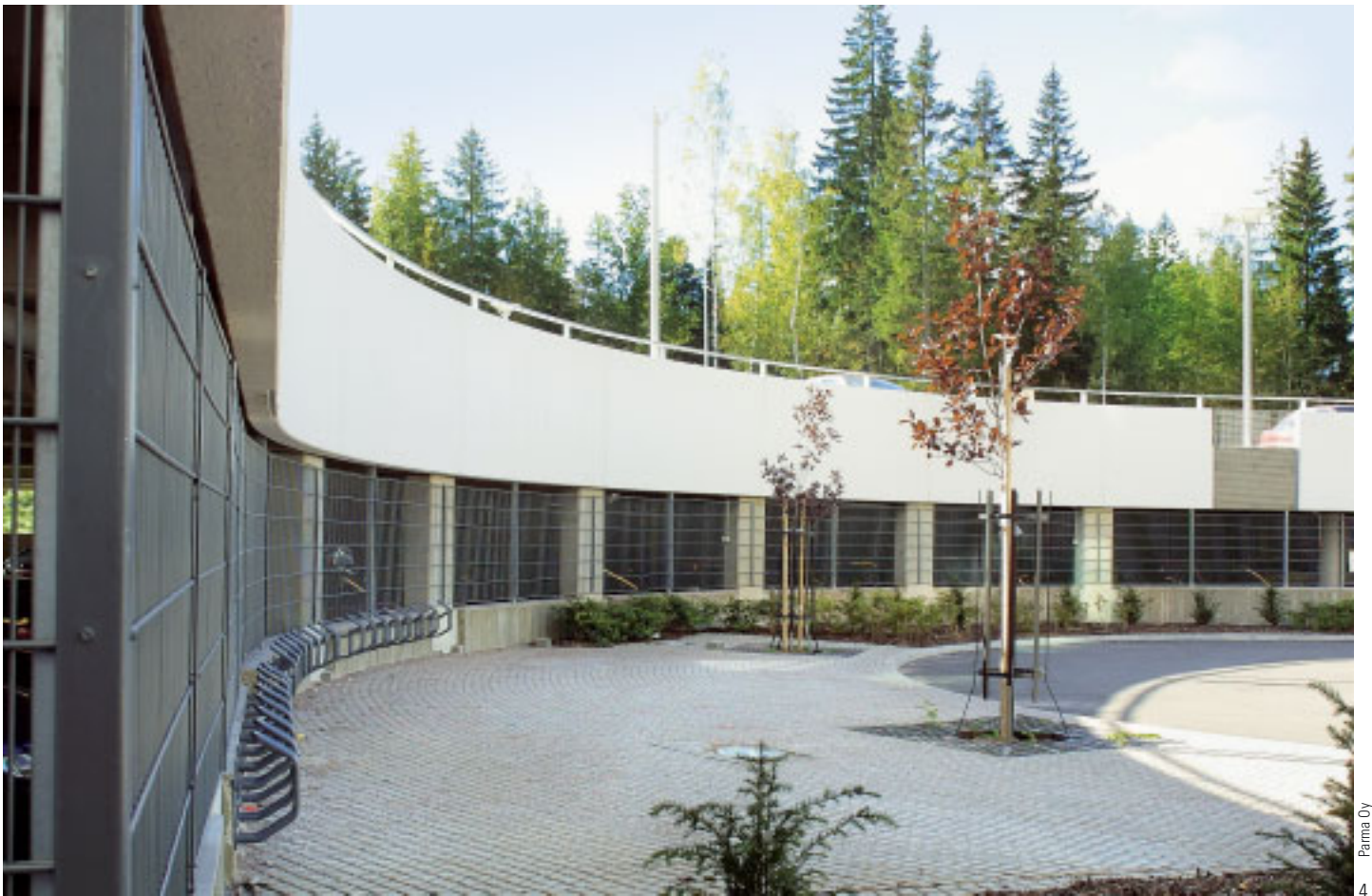
4, 6 Kvarteton pysäköintilaitos, Leppävaara, Espoo. Tasot on tehty Parma Oy:n kuorilaattarakenteena.
