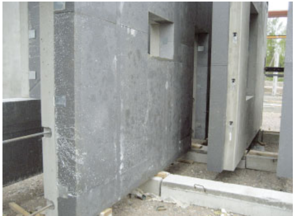
11 Seinässä Platina-eristeellä voidaan helposti toteuttaa U-arvoltaan 0,10 - 0,14 W/m 2 K rakenteita. 180 mm paksulla Platina-seinäeristeellä saavutetaan ensi vuonna vaadittava U = 0,17 W/m 2 K.
