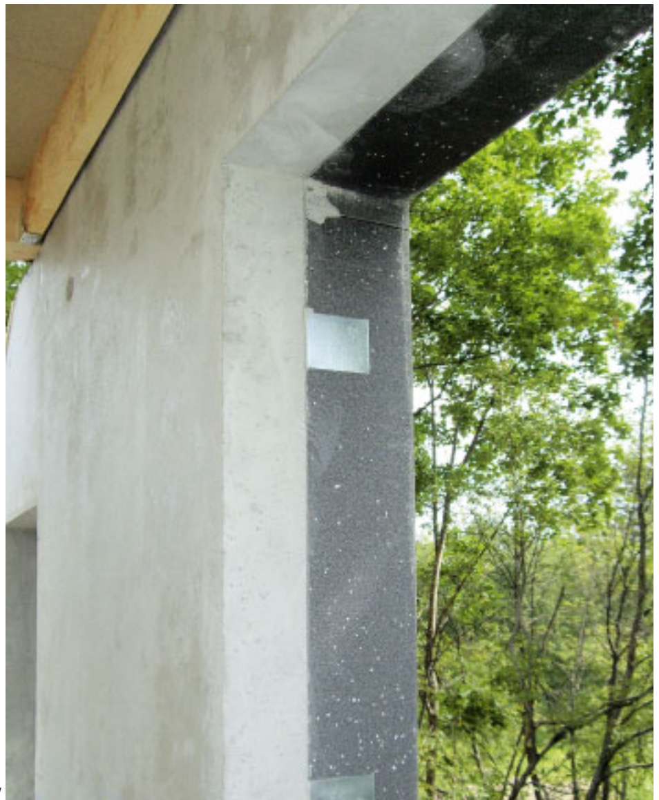
7 Thermisol Platina -eristeen ja seinärakenteen ikkunaliitos.
