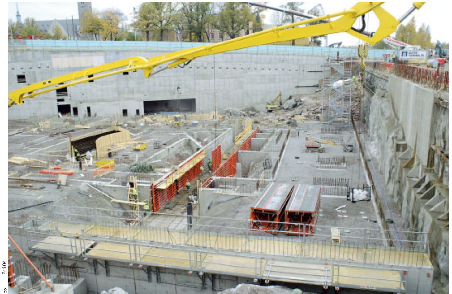
8 Pohjaveden kurissa pitävät porapaalupatoseinät, huoltotunneli sekä pohjatyöt ja talon perustukset ovat jo jääneet näkymättömiin. Rakennus on kokonaan kallion varassa. Kallion pohja on injektoitu ja sen päällä on noin 70 sentin salaajitettu sepelikerros. Porattu suurpaalupatoseinä on vajaat kaksi metriä kallion sisällä.
