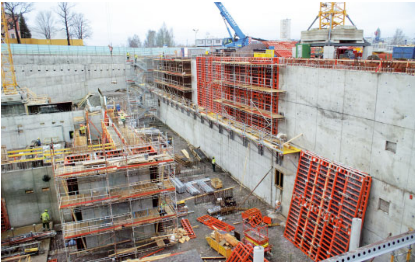
8 Pohjaveden kurissa pitävät porapaalupatoseinät, huoltotunneli sekä pohjatyöt ja talon perustukset ovat jo jääneet näkymättömiin. Rakennus on kokonaan kallion varassa. Kallion pohja on injektoitu ja sen päällä on noin 70 sentin salaajitettu sepelikerros. Porattu suurpaalupatoseinä on vajaat kaksi metriä kallion sisällä.
