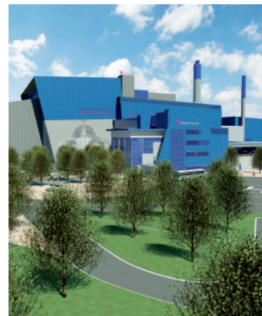
54 Vantaan Energian jätevoimala
