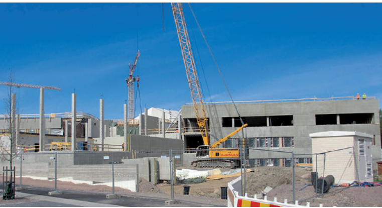
20 Aurinkokiven palvelukeskuksen työmaa käynnissä kesällä 2015.
