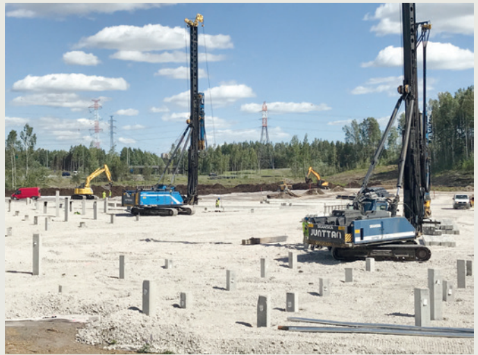
1 Helsinki Outlet on Vuoden 2018 Paalutustyömaa.
