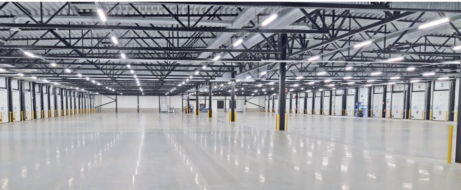
3 Postin terminaalin kiiltohiottu betonilattia Pirkkalassa.
