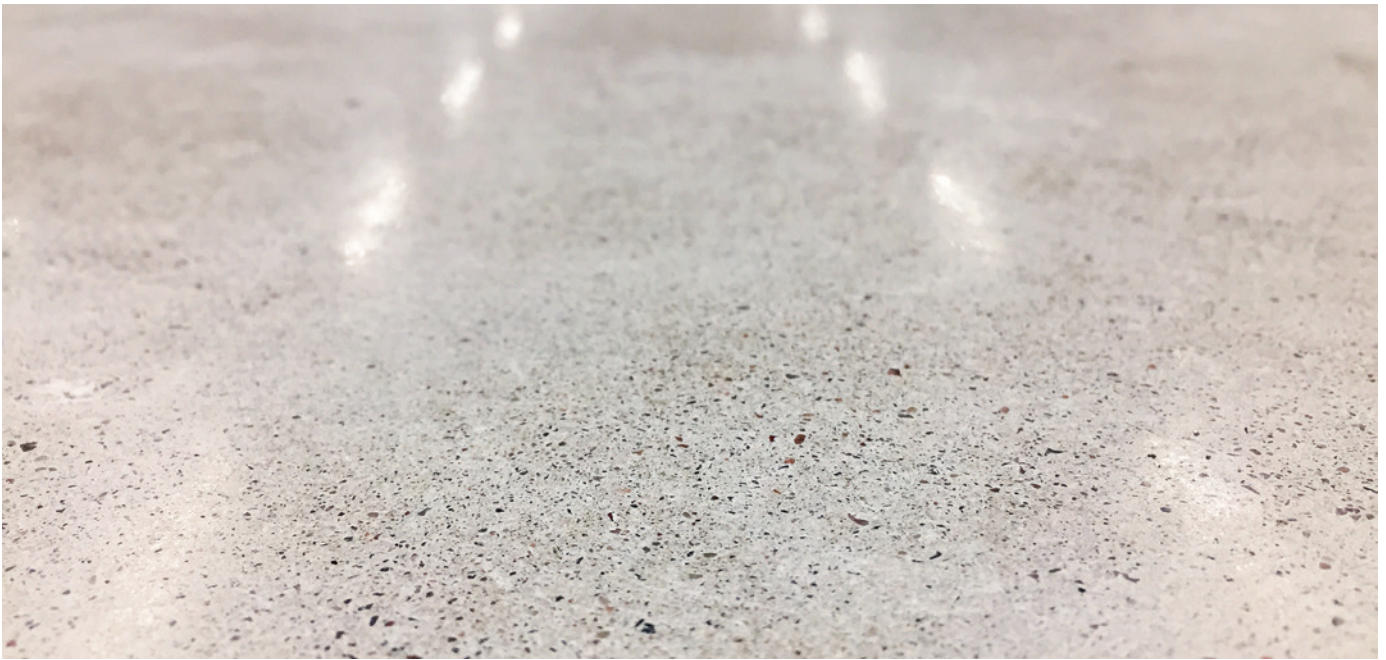
4 HUB Logistiikan terminaalin kiiltohiottu betonilattia Vantaalla.
