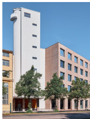
10 Vuoden 2021 Betonirakenne: Taideyliopiston Mylly
