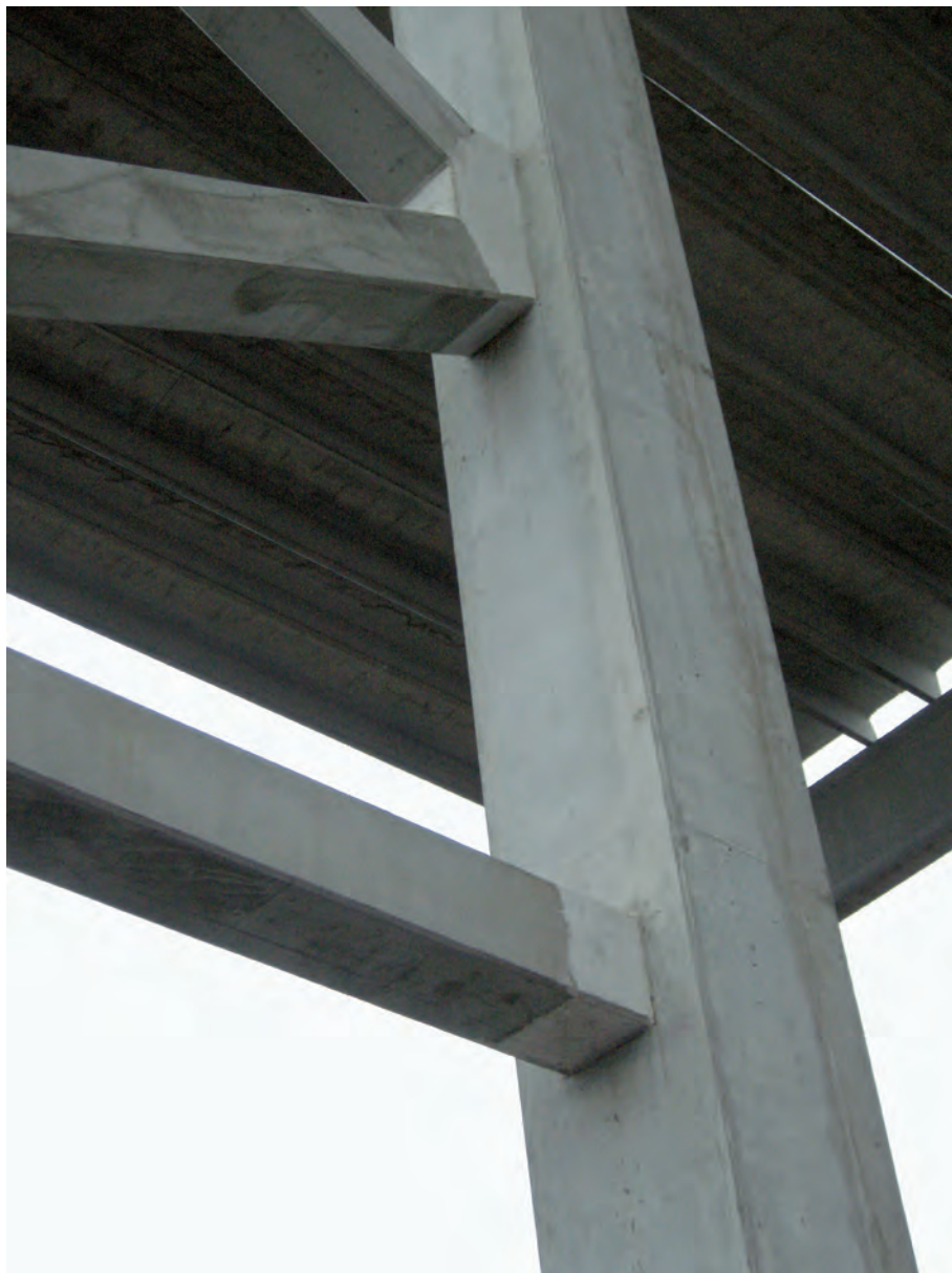
3 Betoniristikon sauvojen liitokset valettuna.
