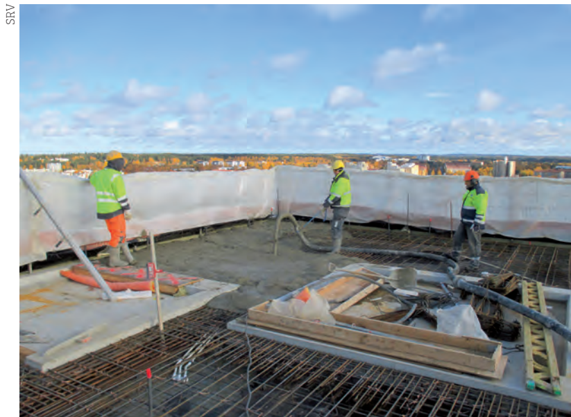
18 Välipohjaholvin valua. Kuvassa näkyvät kylpyhuone-elementtien alustana toimivat teräsbetoniset välipohjaelementit.
