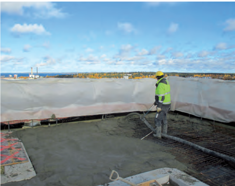
17 Betonin pumppaus ja valu käynnissä.
