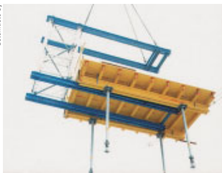
7 Pöytämuotin nostohaarukka. Isoissa parkkitaloissa talou- dellinen vaihtoehto on tehdä muoteista siirrettäviä pöytä- muotteja.
