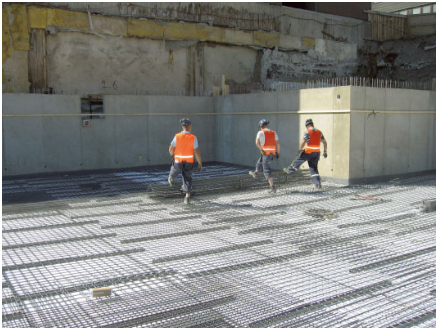
9 Bamtec matoraudoitteiden asennus kerrostalokorttelin alapohjassa.
