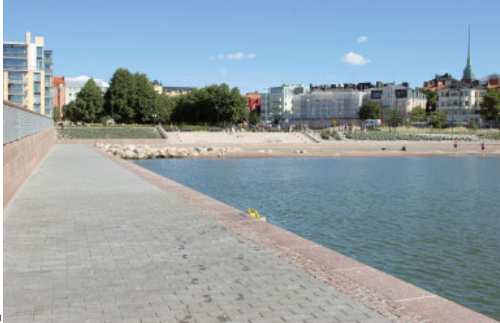
10 Betonielementtirakenteinen tukimuuri on verhoiltu luonnonkivellä.
