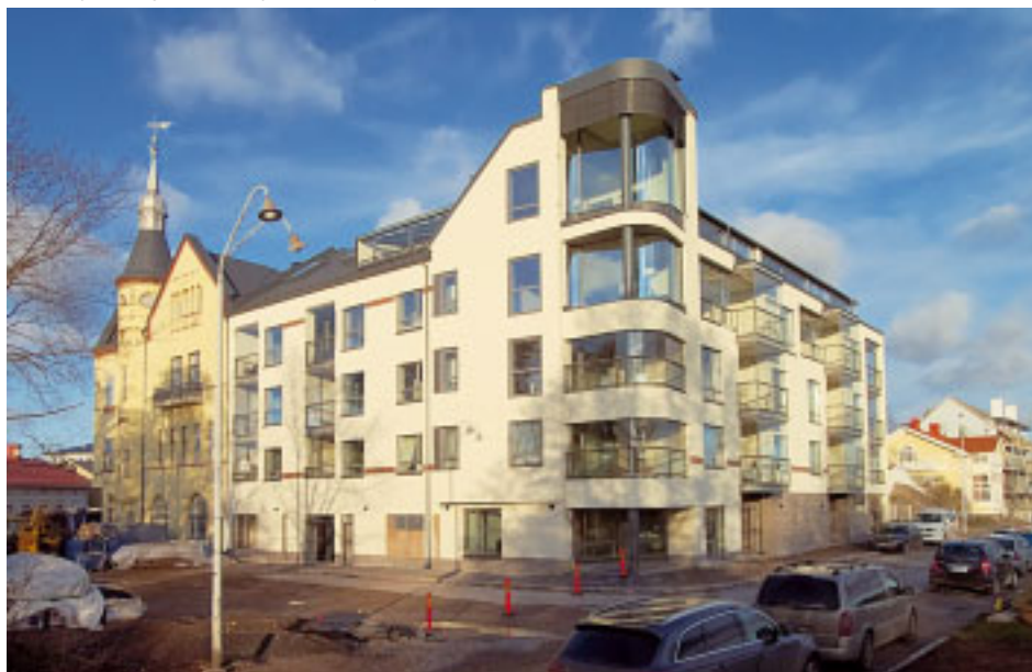
2 Peruskorjattu Regatta-hotelli ja uusi As. Oy Merikatu 1.
