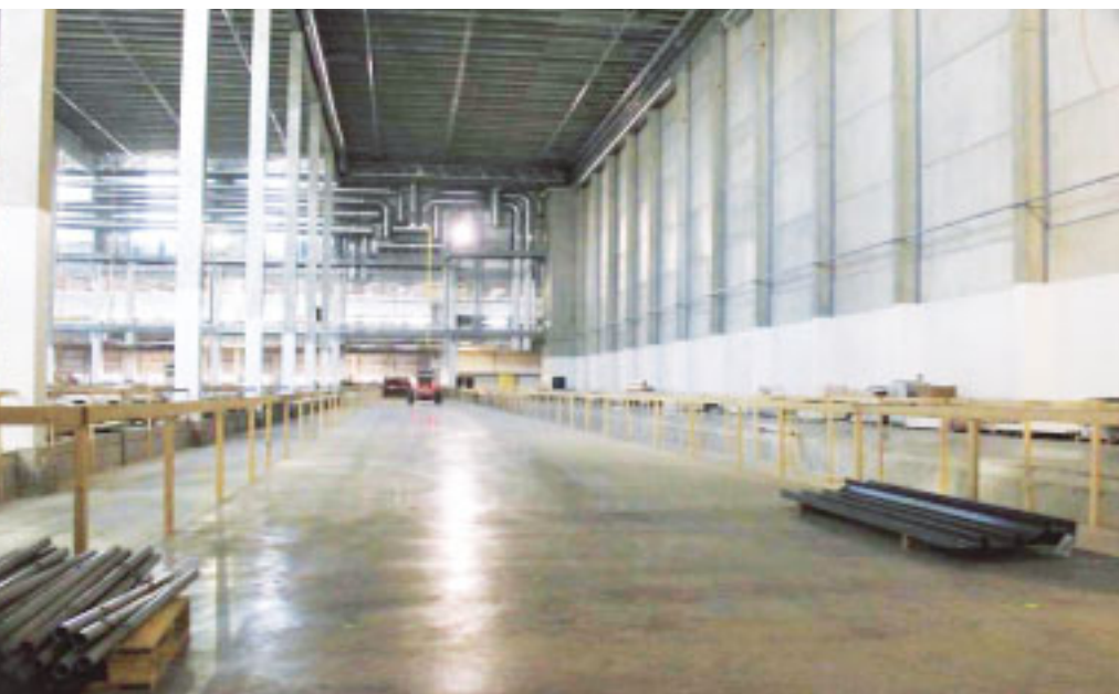
16 Valmis lattia. Hyllyjen runkojen asennus on aloitettu.
