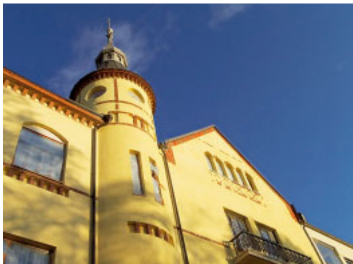
5 Hotelli Regattan julkisivut peruskorjattuna.
