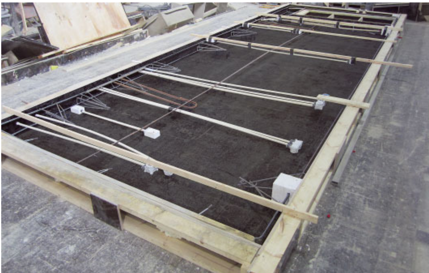
6 Kuvan 2 piirustuksessa esitetyn väliseinäelementin malliasennus.
