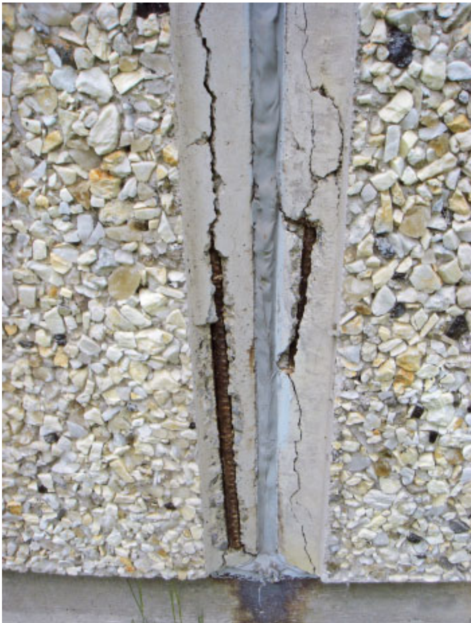
3 Tyypillisimmin korroosioaurioita esiintyy elementtien sellaisten pieliterästen kohdilla, joissa peitepaksuudet ovat pieniä ja saderasitus suurta.
