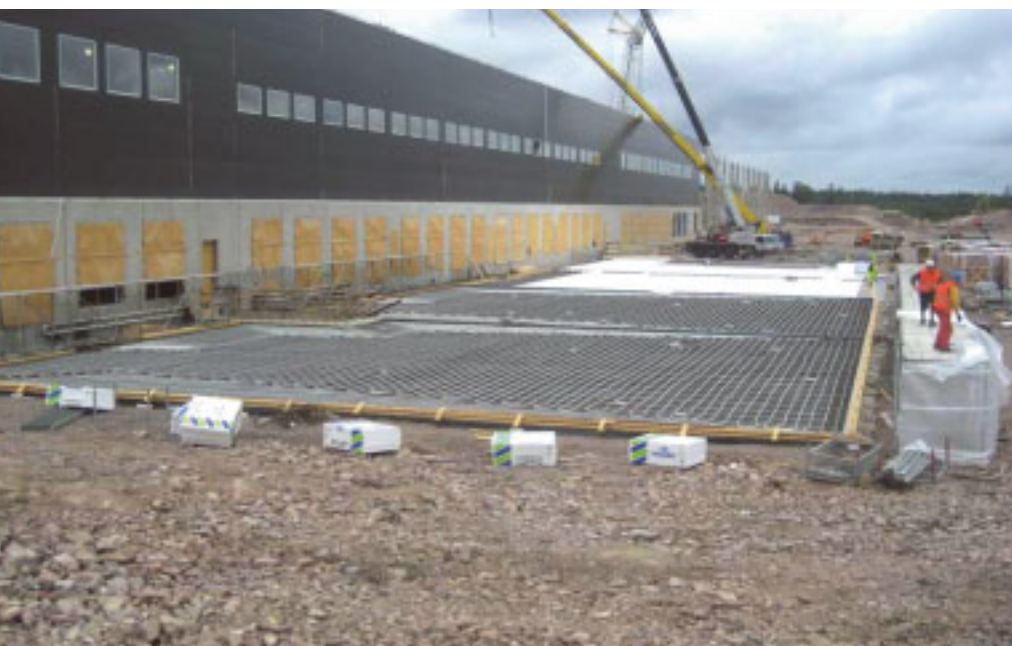
17 Ulkopuolinen raudoitettu betonilaatta.
