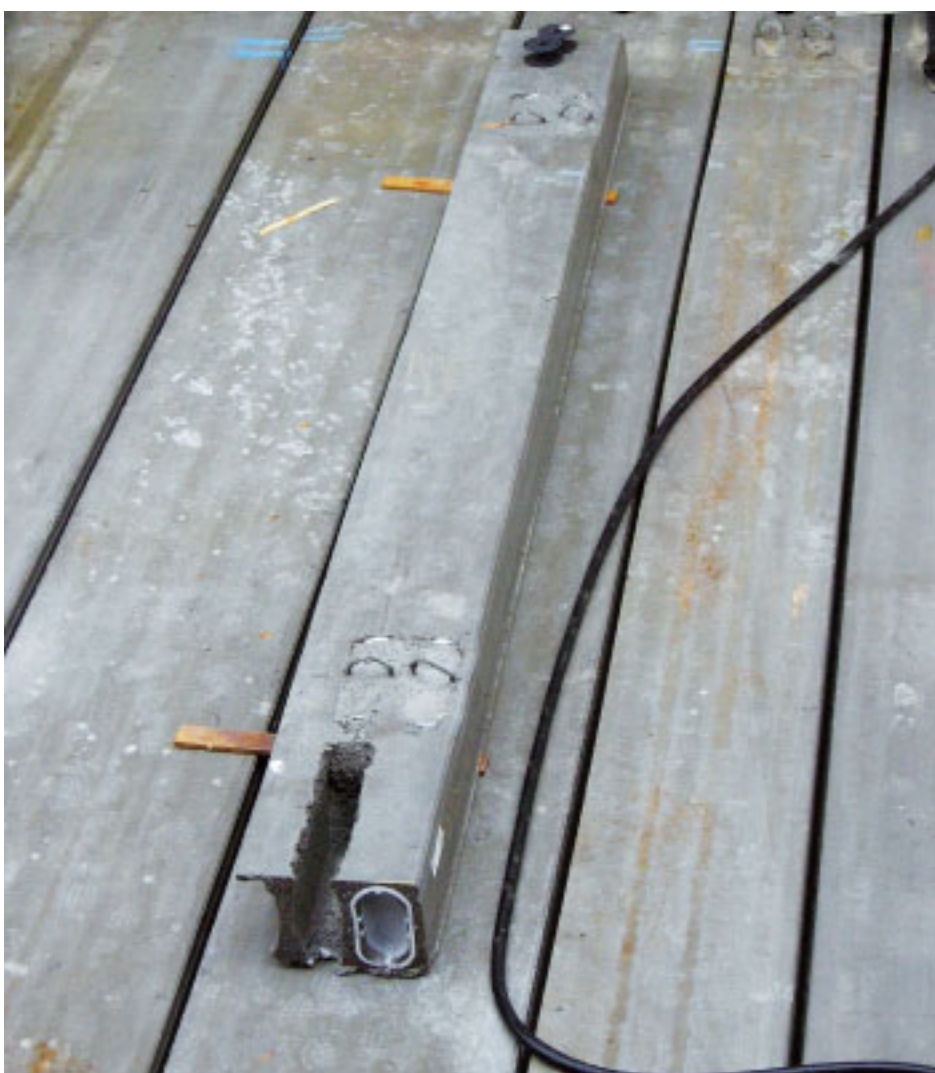
7 Kavennettuihin laattoihin suositellaan asennettavaksi nostolenkit.
