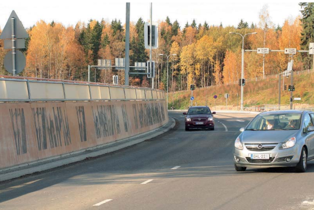
9 Ylismäentien betoninen melumuuri Espoossa.
