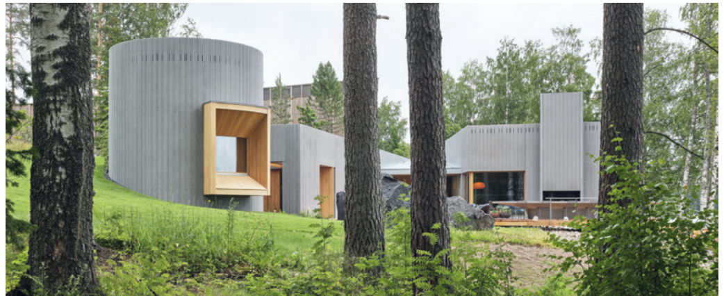
8 Vuoden 2022 Betonirakenne: Serlachiuksen Taidesauna
