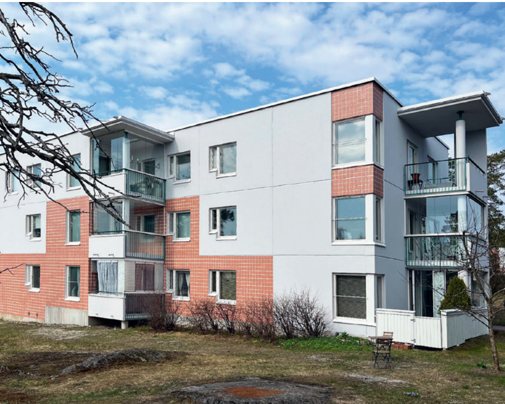
3 Kilpailussa haettiin ideoita Helsingin Meri-Rastilassa sijaitsevan Asunto Oy Rastilankallion asuin-kerrostalojen korjaamiseksi ja uudistamiseksi.
