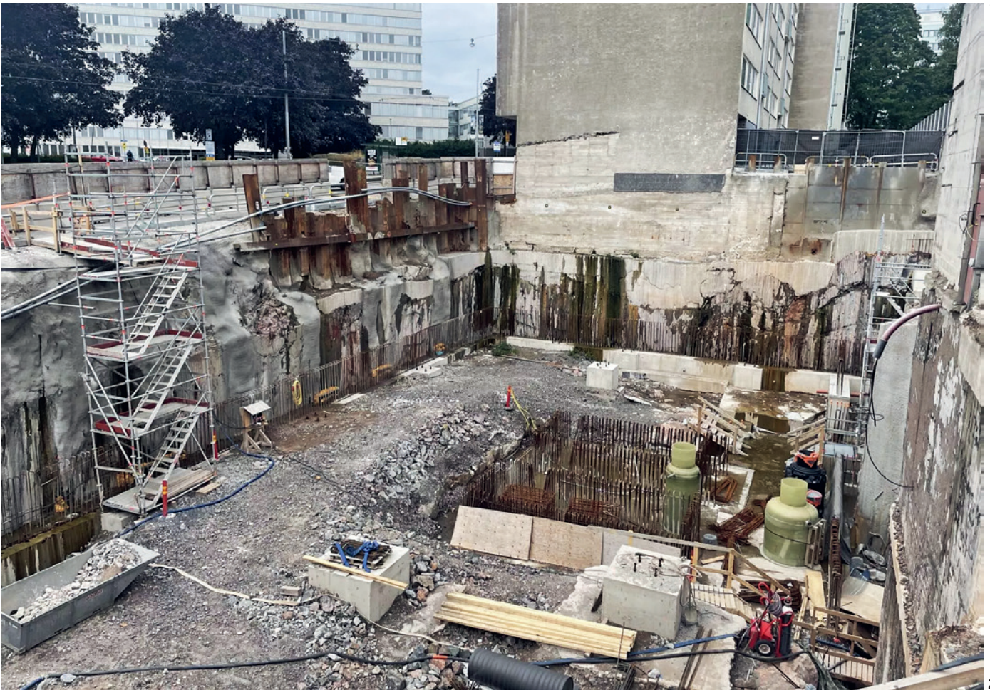
Otu Maru Betonitööd
