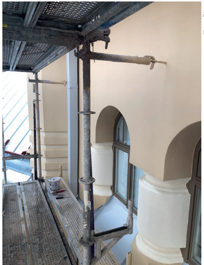
13 Kuvassa pilarit ja detaljit sekä julkisivupinnat korjauksen jälkeen.
