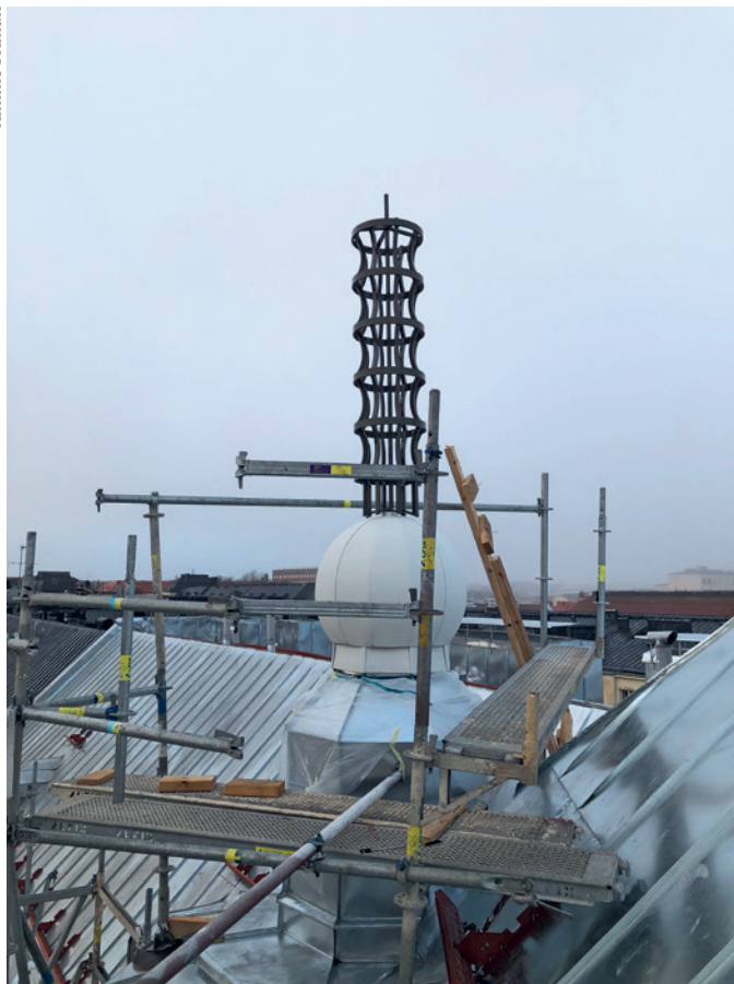
15 Katon piikkimäiset suipot tornit eli spiraat yksityiskohtineen toteutettiin mahdollisimman alkuperäisinä. Kuvassa katon korjauksen työmaavaihe.
