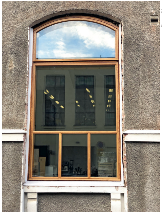
11 Uudet liiketilojen ikkunat uusittiin ja ne ovat tammiset.
