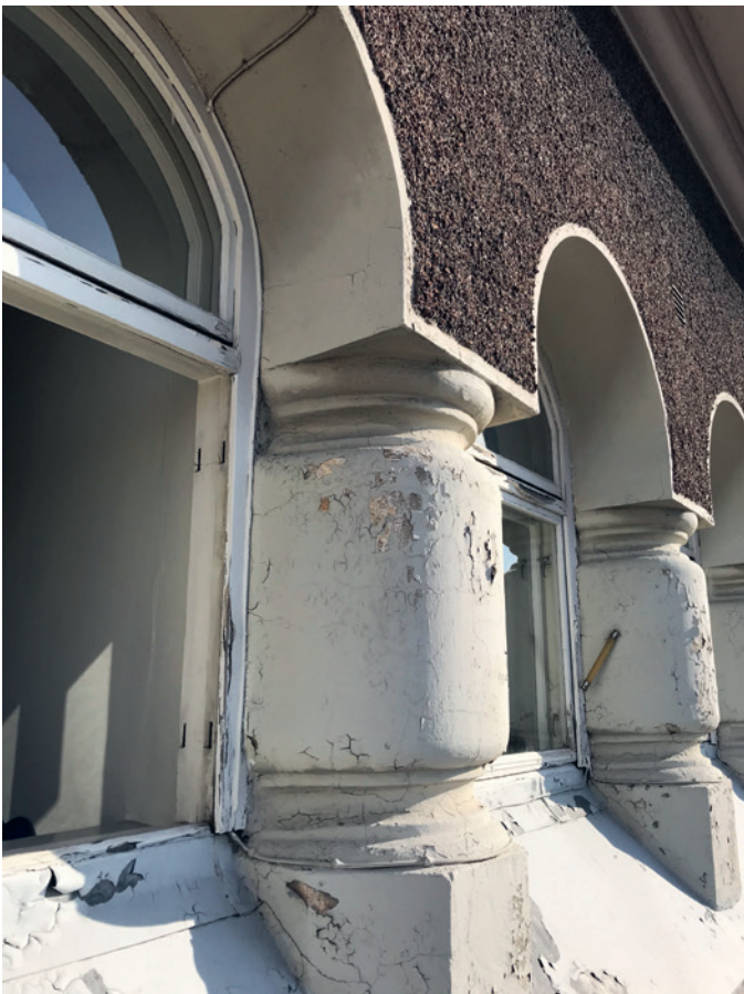
12 Julkisivun vanhat pilari- ja detaljit kunnostettiin. Kuva ennen korjausta.
