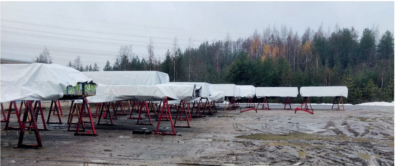
5 Uudelleenkäytettäviä elementtejä välivarastossa.
