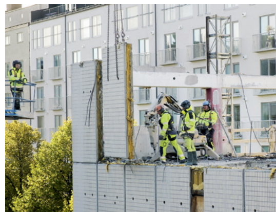
38 Betonielementtien irrottaminen ehjänä uudelleenkäyttöä varten
