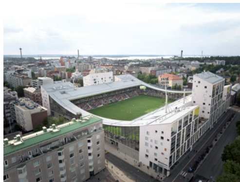
8 Vuoden betonirakenne 2024: Tammelan Stadion
