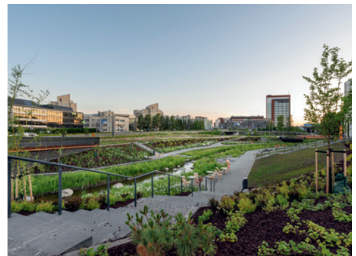
24 Vuoden Ympäristörakenne 2024: Espoon Hatsinanpuisto
