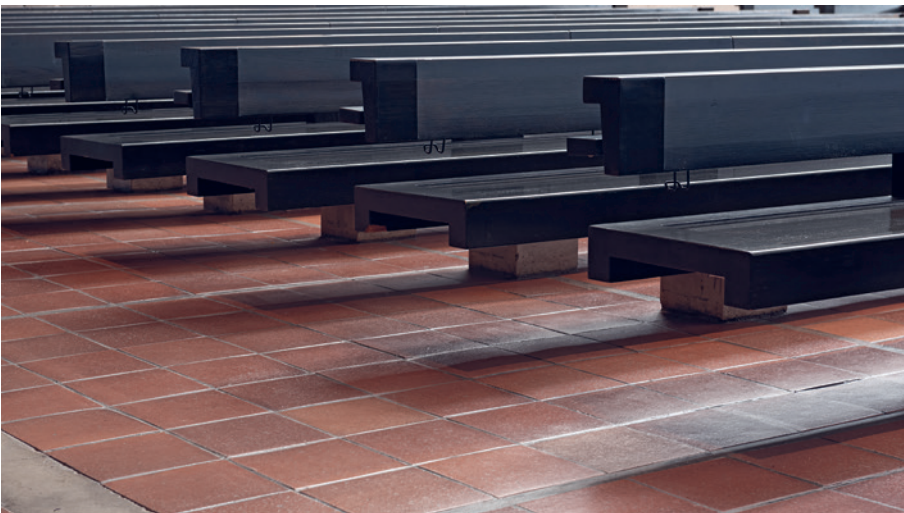
14a Kuorin pitkä seinä, alttarialue. Lattiakanaalidetali.
