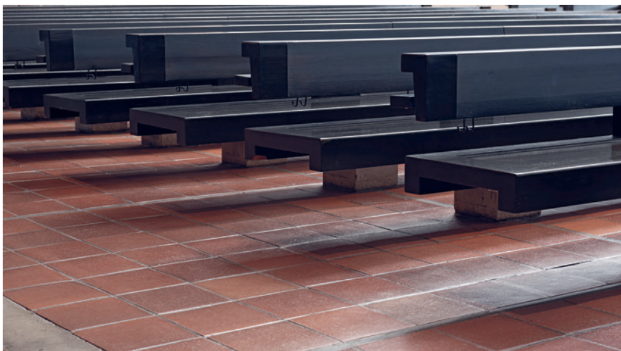
14a Kuorin pitkä seinä, alttarialue. Lattiakanaalidetali.
