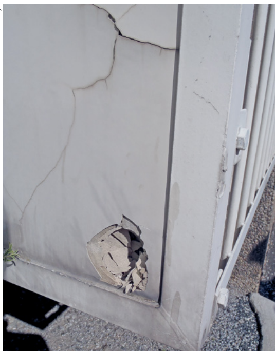
9 Kevytrakenteisen kaiteen levyn säilytyminen kaiteen alaprofiiliin kertyneen kosteuden seurauksena.
